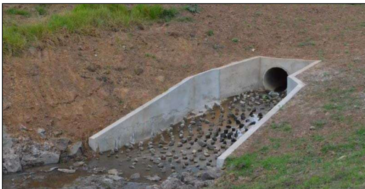
Figura 34. Exemplo de dissipador de energia.
