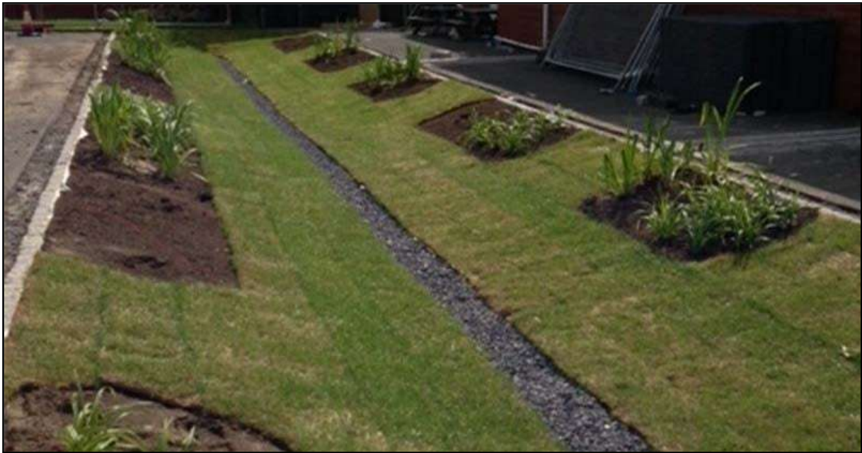
Figura 36. Exemplo de vala de infiltração.
