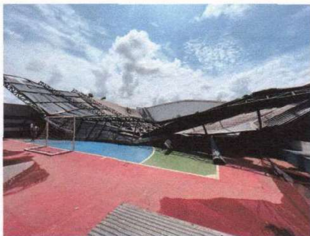
Vista interna da quadra com detalhe para a cobertura destruída.
