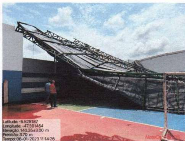
Vista interna da quadra com detalhe para a cobertura destruída.
