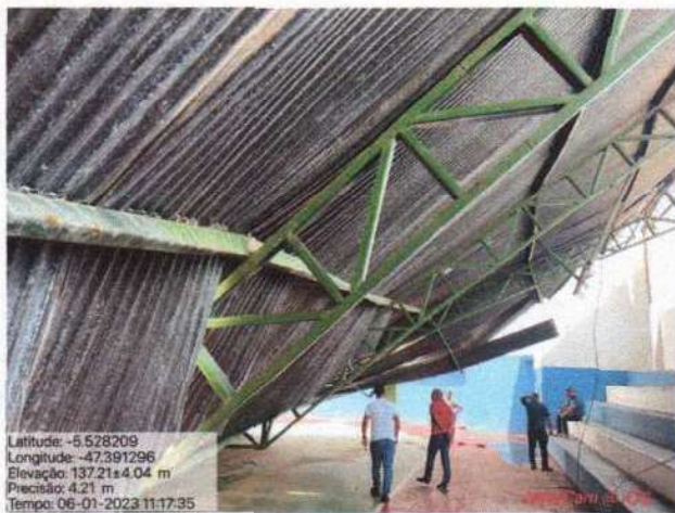
Vista interna da quadra com detalhe para a cobertura destruída.
