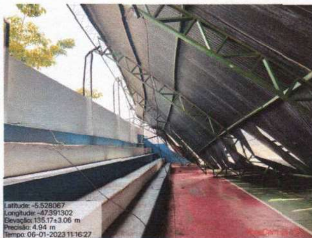
Vista interna da quadra com detalhe para a cobertura destruída.
