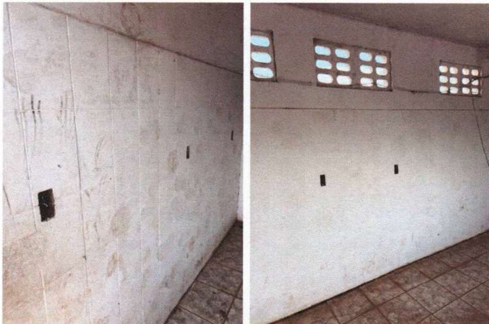
Vista interna dos vestiários com detalhes para os revestimentos de paredes e piso
