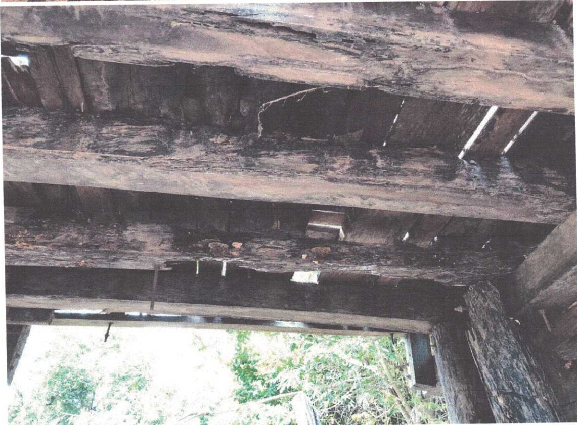
Ponte sobre o Rio Cacaú
