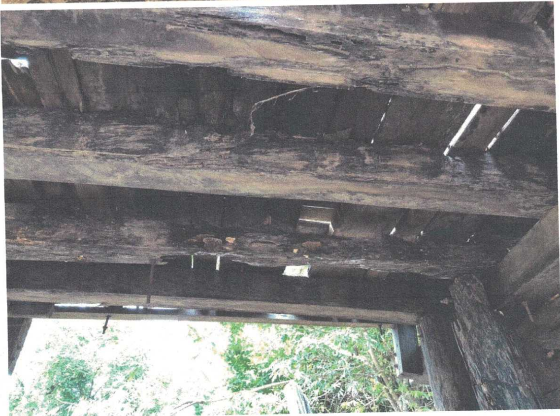
Ponte sobre o Rio Cacaú
