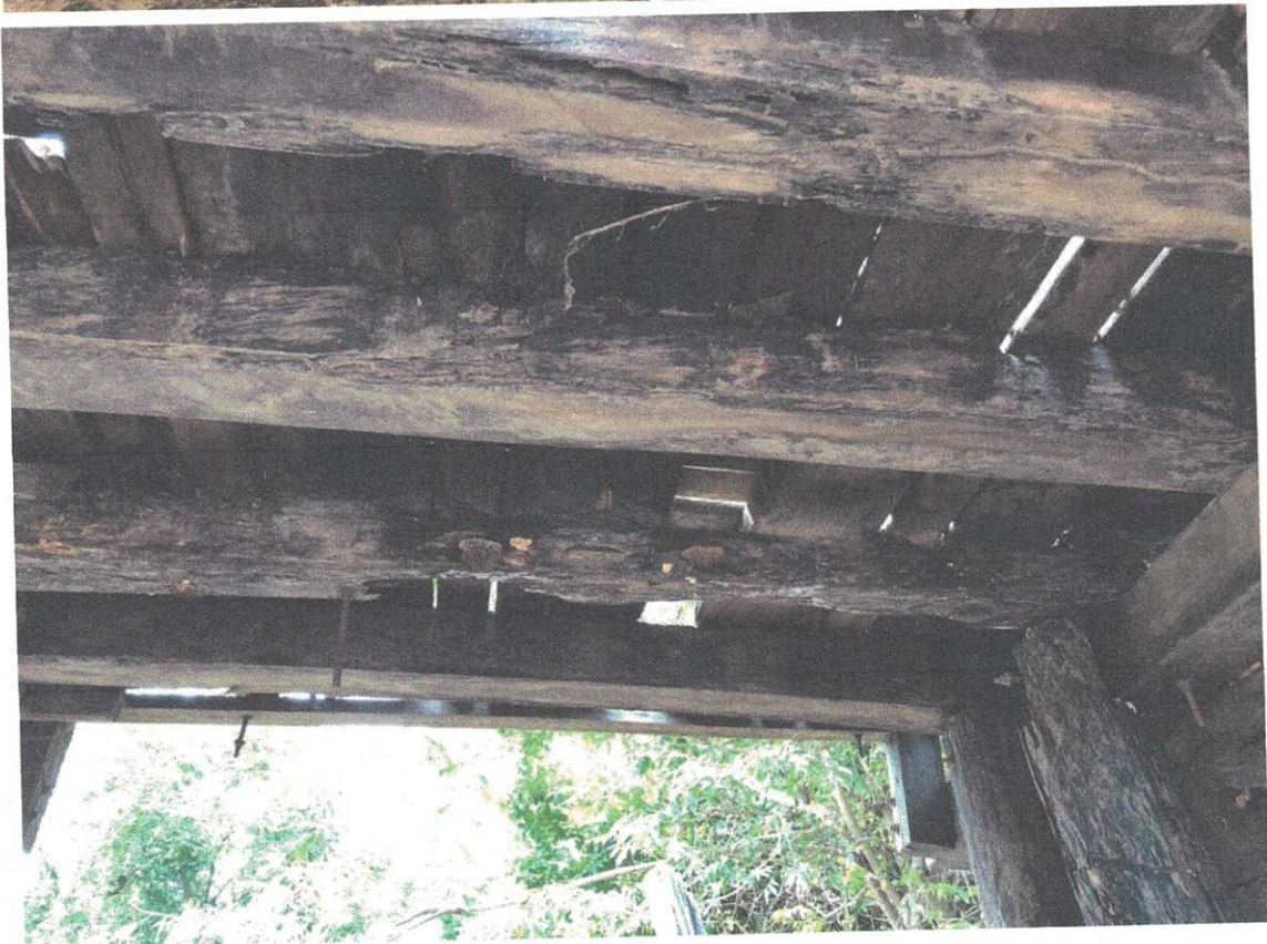
Ponte sobre o Rio Cacaú
